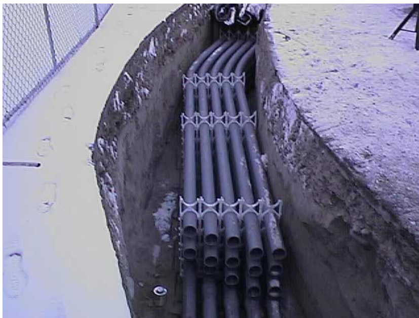
Slika 9.18. Cijevni blok prije betoniranja
