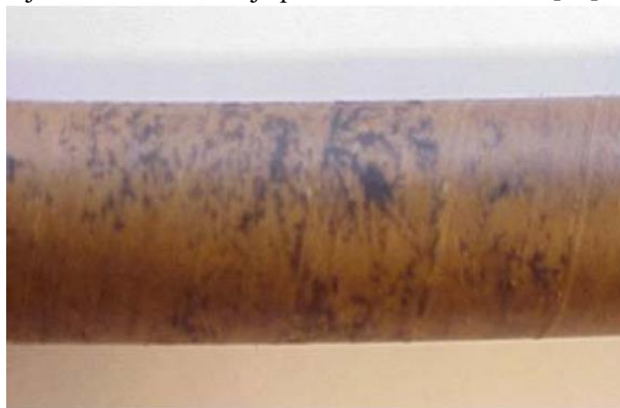
Slika 11.11. Oštećenja na papirnoj izolaciji uzrokovana isušivanjem zbog povišenih temperatura
