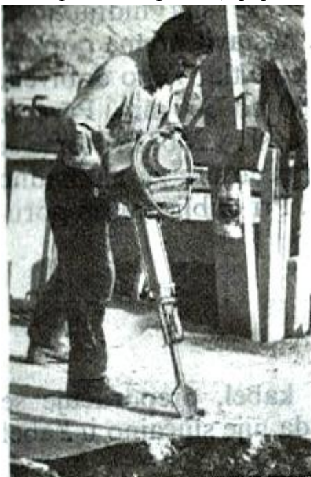
Slika 9.1. Iskop kabelskog rova (u popločanoj ulici)
