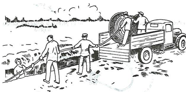
Slika 9.5. Polaganje kabela sa vozila [5]
