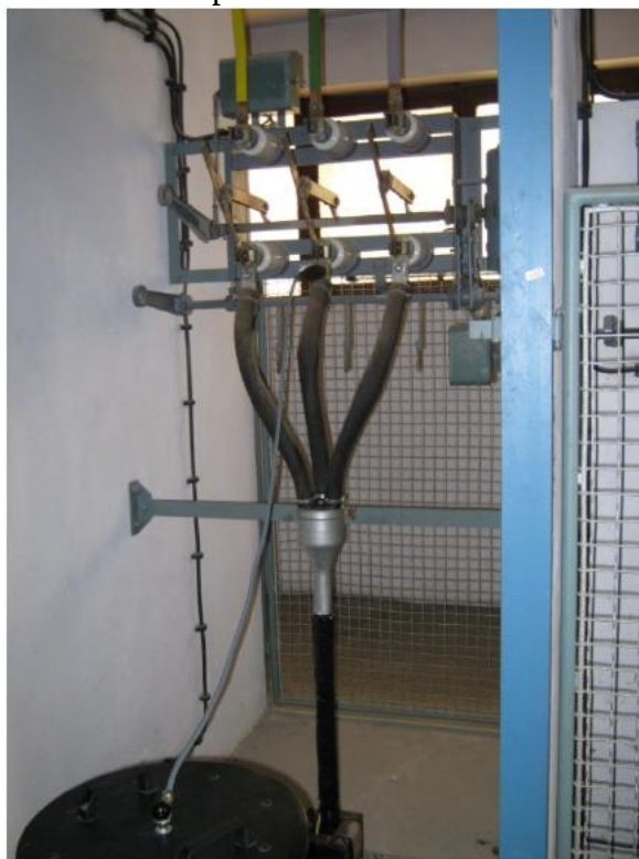
Slika 11.22. Trožilni 10kV kabel na kojem je izvršeno ispitivanje stanja izolacije pomoću OWTS uređaja
