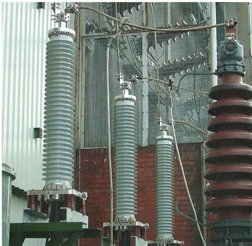
Vanjski kompozitni završeci OHVT od 123 kV do 170 kV
